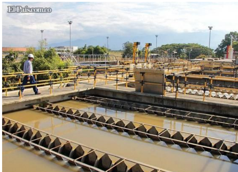
Las plantas Puerto Mallarino y Río Cauca han suspendido sus operaciones en 38 ocasiones durante el 2012, debido a la alta turbiedad del río Cauca, según Emcali.
