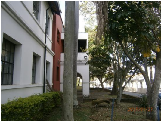
Luminarias del Edificio 130, "Luis Heladio Perla", Campus San Fernando
