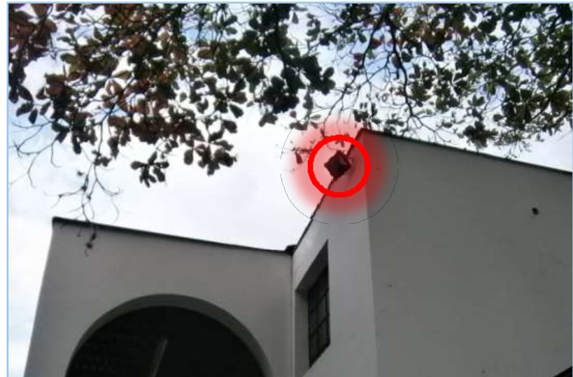
Instalación de luminaria -lado sur Edificio 130
