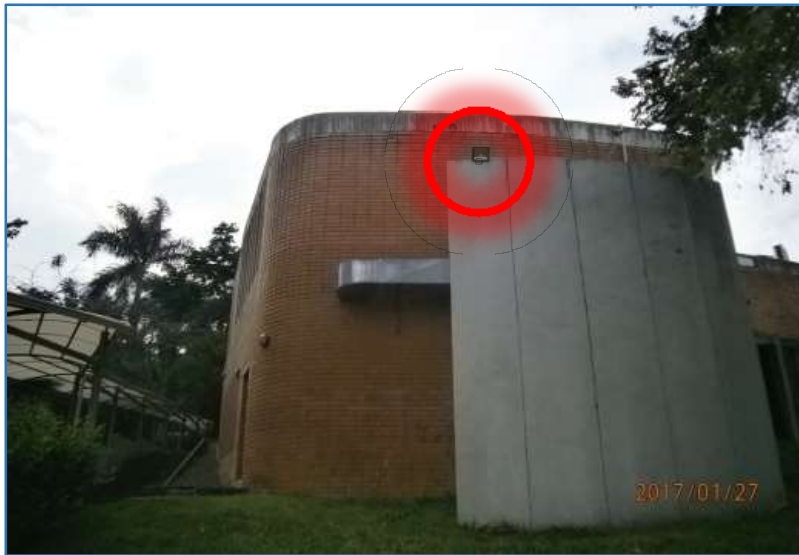
Instalación de luminarias en zonas de penumbra pronunciada
