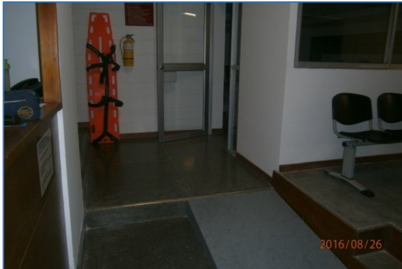
Enlucimiento sala SINSA, Edf. 122A – Rampa de acceso para personas con discapacidad
