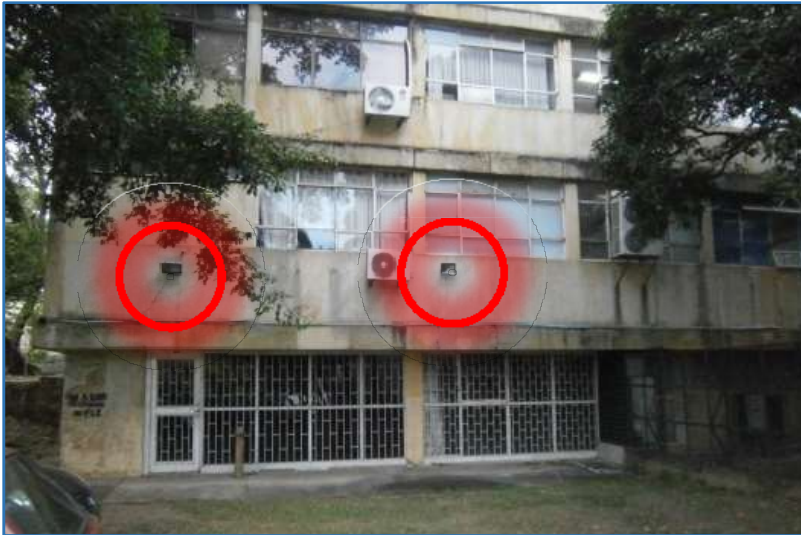
Instalación luminarias -Edificio 118
