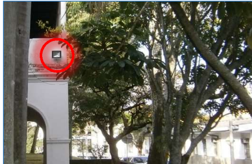
Instalación luminarias -Edificio 130
