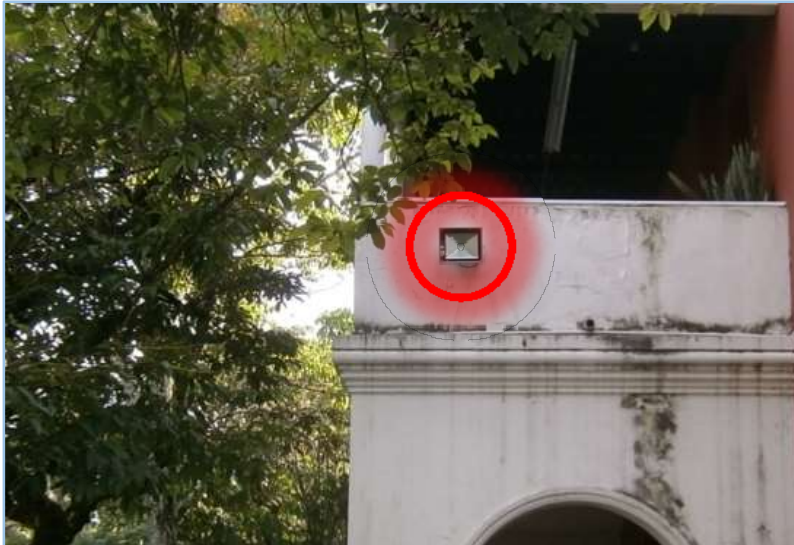
Instalación luminaria - Edificio 130
