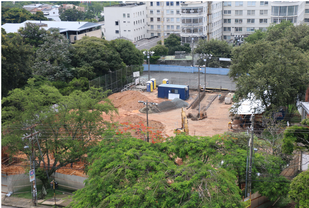
Intervención al CDU-Campus de San Fernando
