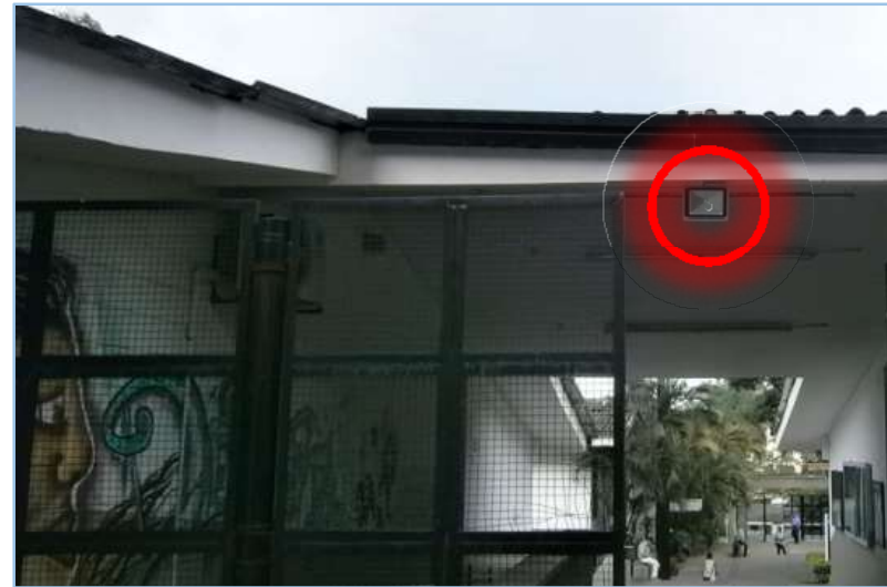
Instalación luminaria –Pasillo Biblioteca
